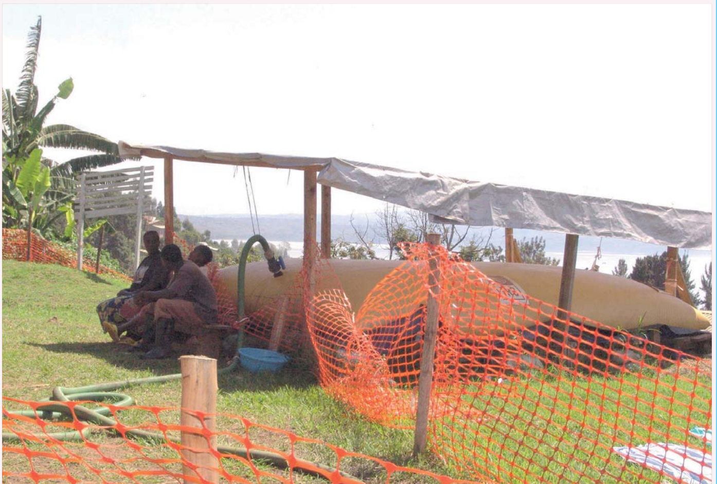
Un bladder pour fournir de l'eau potable au sein de l'hôpital provincial de Bukavu, Chef-lieu du Kivu, actuellement en pleine épidémie de choléra (photo: OMS).
